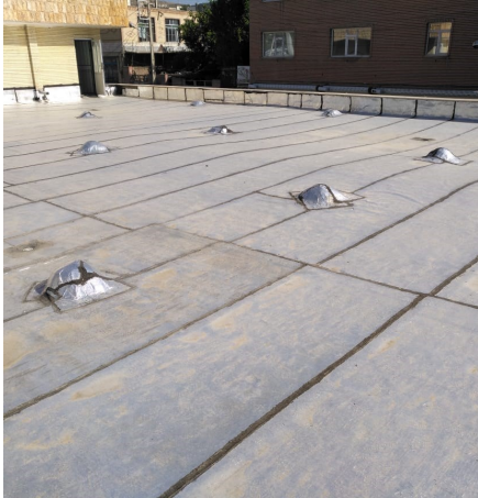
ایزوگام ساختمان تعدادی از مراکز
