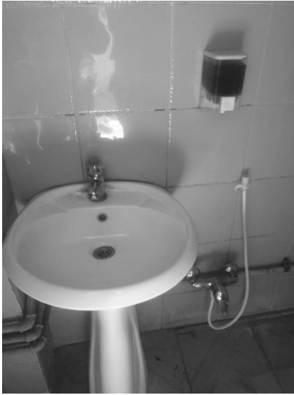
تعمیر سرویس بهداشتی مرکز دولت آباد
